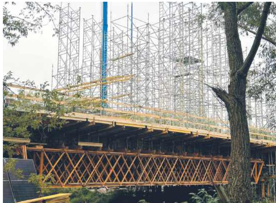
Budowa przeprawy mostowej
