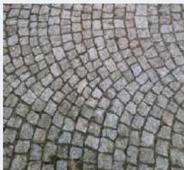
❶ Drobnią kostkę z granitu ułożono w wachlarze, otoczono obrzeżem z cementu i dużej kostki.
