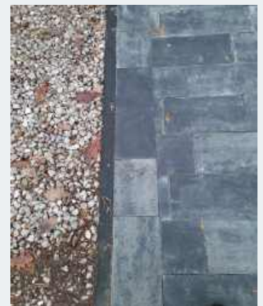
❷ Obrzeża wykonano z gęstego betonu, na którym umocowano gotowe krawężniki.
