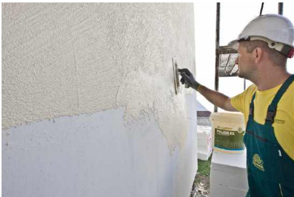
🔑 Najpopularniejsze wykończenie ściany dwuwarstwowej, czyli tynk cienkowarstwowy. GREINPLAST
