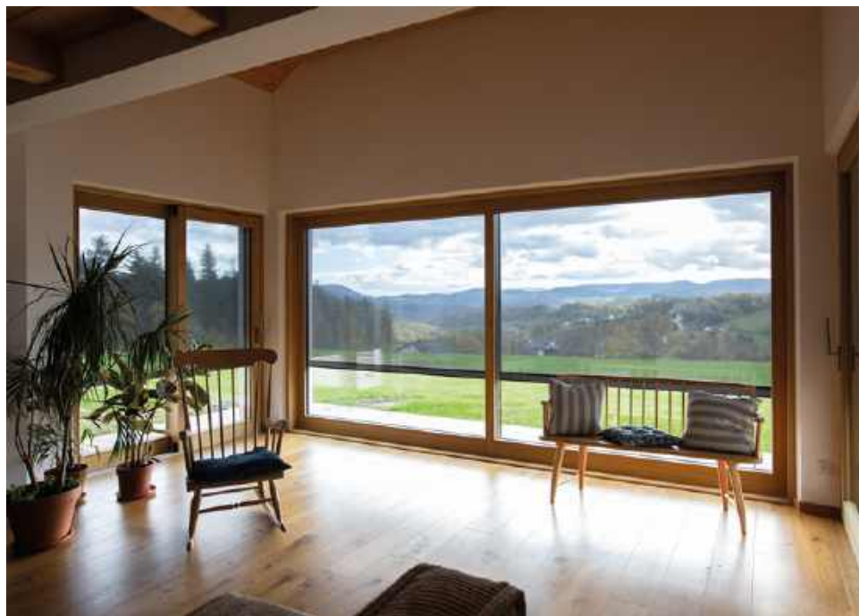
● Panoramiczne przeszklenia mogą być montowane na stałe i się nie otwierać, co pozwoli ograniczyć koszty. Rozwiązanie to sprawdzi się pod warunkiem, że na sąsiedniej ścianie umieścimy osobne drzwi tarasowe. FAKRO
