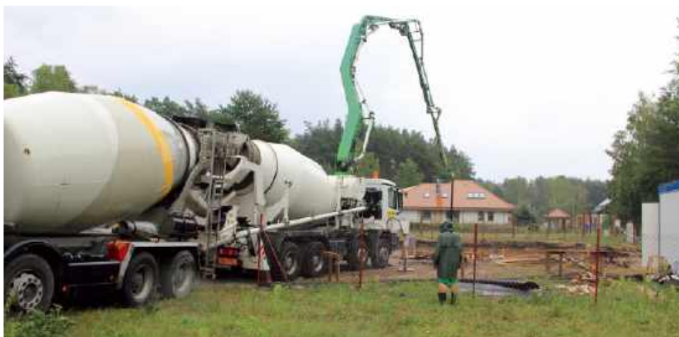
🔧 Stan zero zostanie osiągnięty, gdy budynek urosnie do poziomu podłogi na gruncie. J. WERNER
