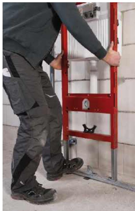
🔧 Stelaż do zabudowy suchej ma postać stalowej ramy, która jest samonośną konstrukcją. Nie trzeba jej niczym wzmacniać – wystarczy zamocować ją do podłogi i ściany. TECE
