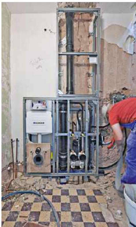
🔧 Wykonanie odpowiednio powiększonej konstrukcji obudowy pozwala ukryć za nią również pion kanalizacyjny. GEBERIT
