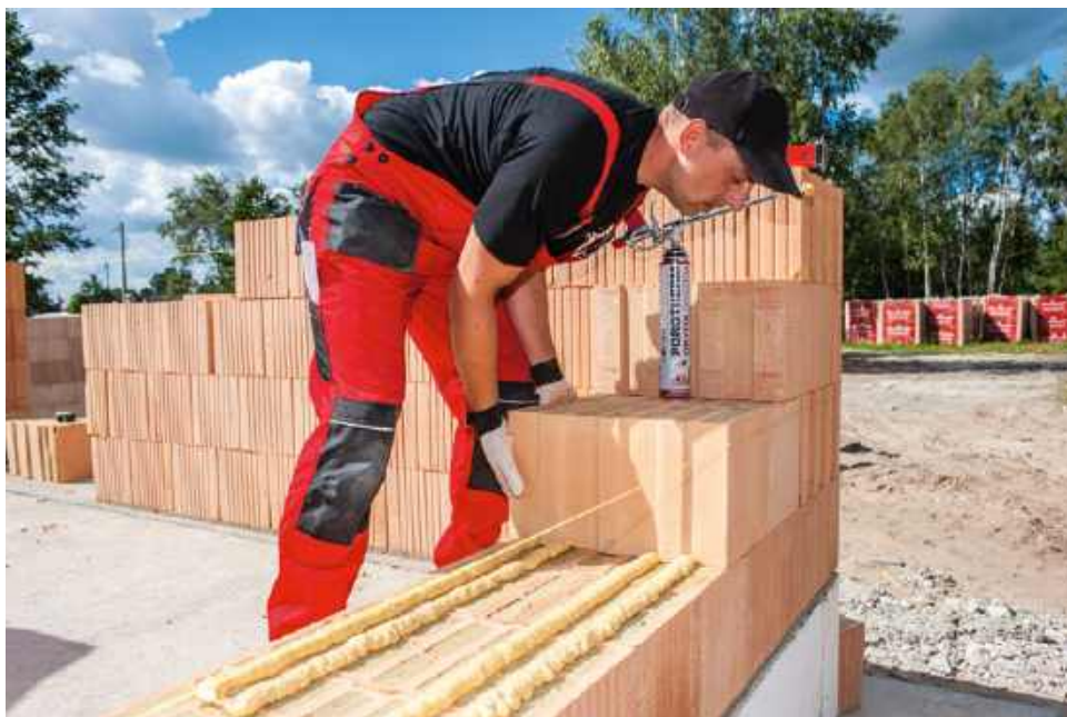
📌 Wykonanie ściany jednowarstwowej wymaga dużej staranności, dlatego do prac trzeba zatrudnić doświadczoną i sprawdzoną ekipę. WIENERBERGER
