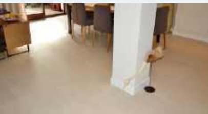
Nowe jasne płyty gresu ułożono na całym parterze, wykorzystano nowoczesne zaprawy.
