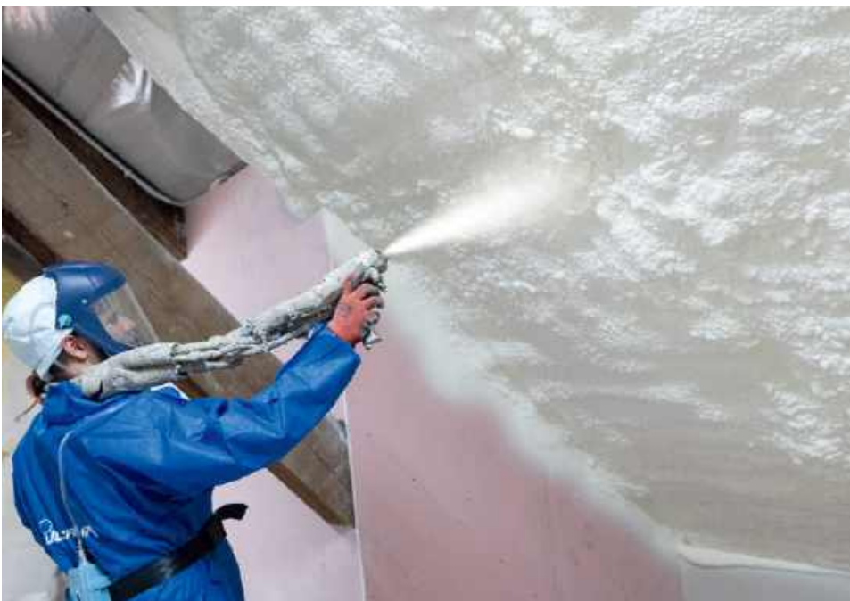
➋ Ocieplanie pianą PUR to zadanie dla odpowiednio wyposażonych fachowców. ULTRAPUR
