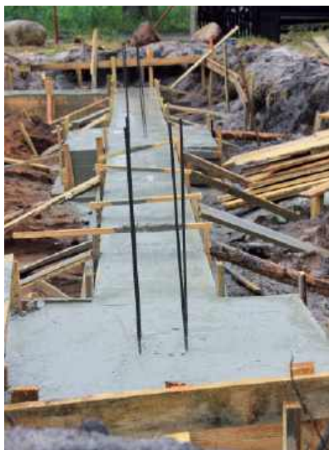
Ławy fundamentowe gotowe. J. WERNER
