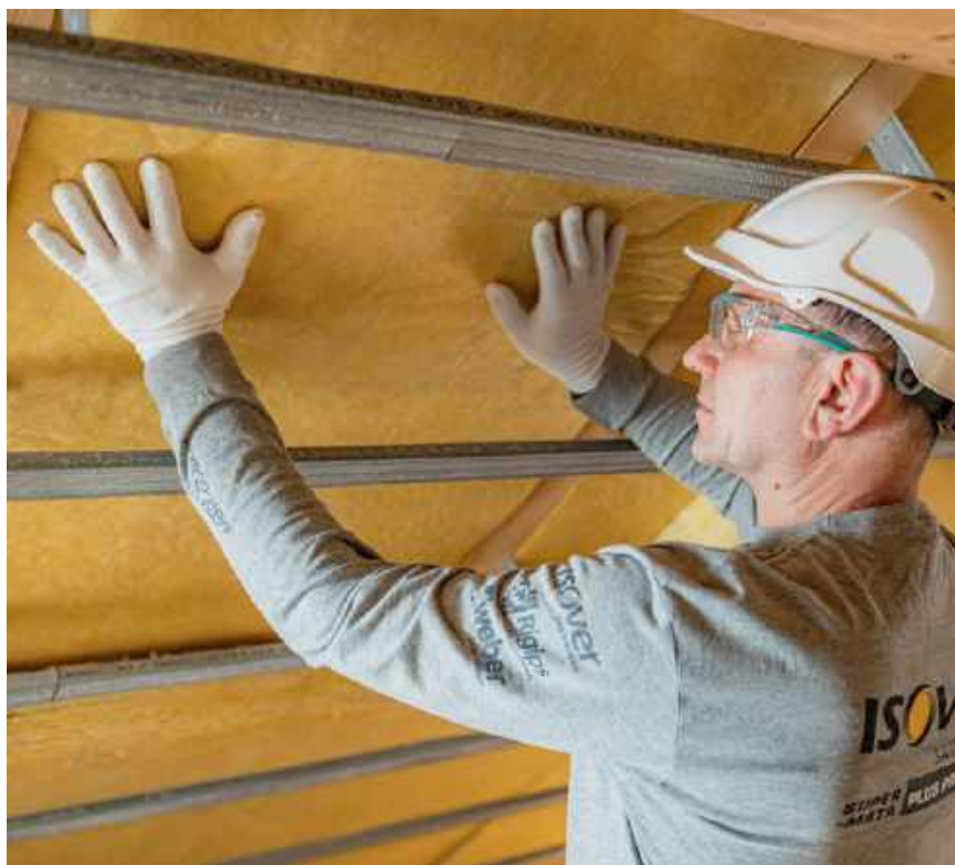
🔧 🧤 Wełna mineralna jest bezkonkurencyjna przy ocieplaniu poddaszy. Dzięki sprężystości włókien dokładnie wypełnia ocieplaną przestrzeń pomiędzy krokwiami. ROCKWOOL, ISOVER
