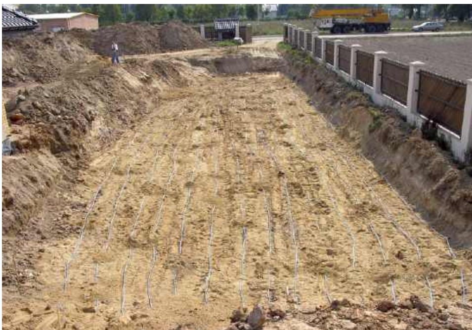
🔧 Pompy gruntowe nie są tak popularne, jak powietrzne, ponieważ budowa źródła dolnego jest droga, a czasami niemożliwa. ARCHIWUM BD
