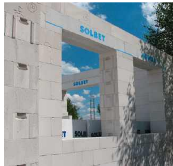
📌 Aby w ścianach jednowarstwowych nie dochodziło do punktowego wychładzania przy nadprożach okien i drzwi oraz wieńcu stropowym, należy stosować specjalne wyroby, które są ocieplane w procesie prefabrykacji. SOLBET
