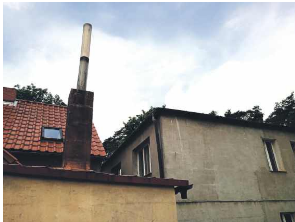
Kotłownia w Jażwinach - oś sąsiedzkiego konfliktu
