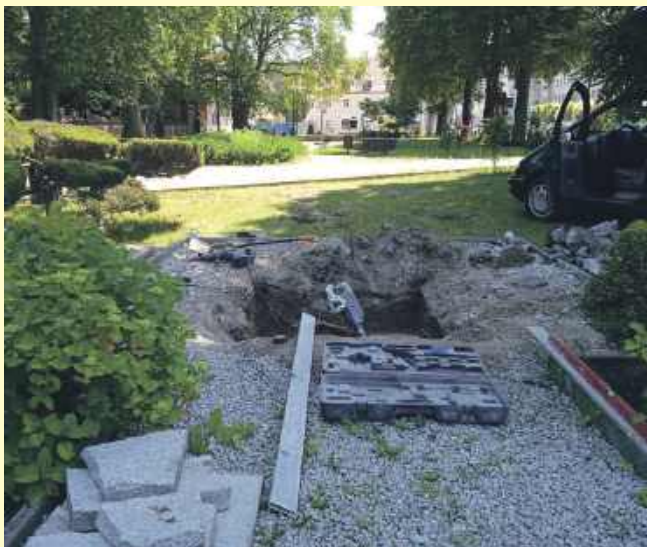
Pomimo upałów trwają prace przy fundamentach pomnika.
