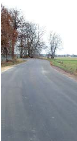
Zakończono przebudowę drogi powiatowej Turów - Siedlanów. Nowa nawierzchnia ma około 665 mb. Wartość prac remontowych to 180 000,00 zł brutto. Wykonawcą robót była firma FEDRO z Osiecka
