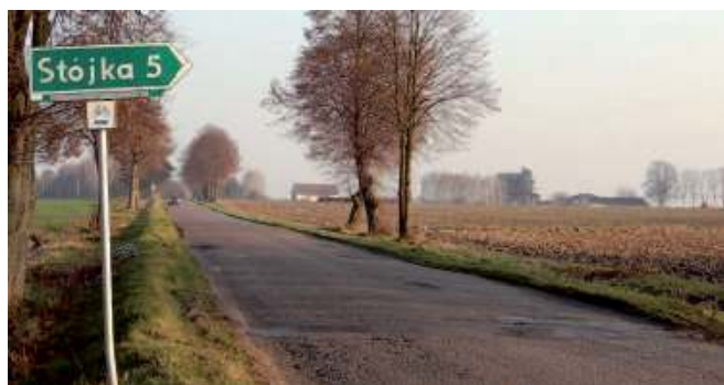
Drogę wyremontowano we współpracy finansowej powiatu radzyńskiego z gminą Czemierniki. Łączny koszt to 600 tys. zł
