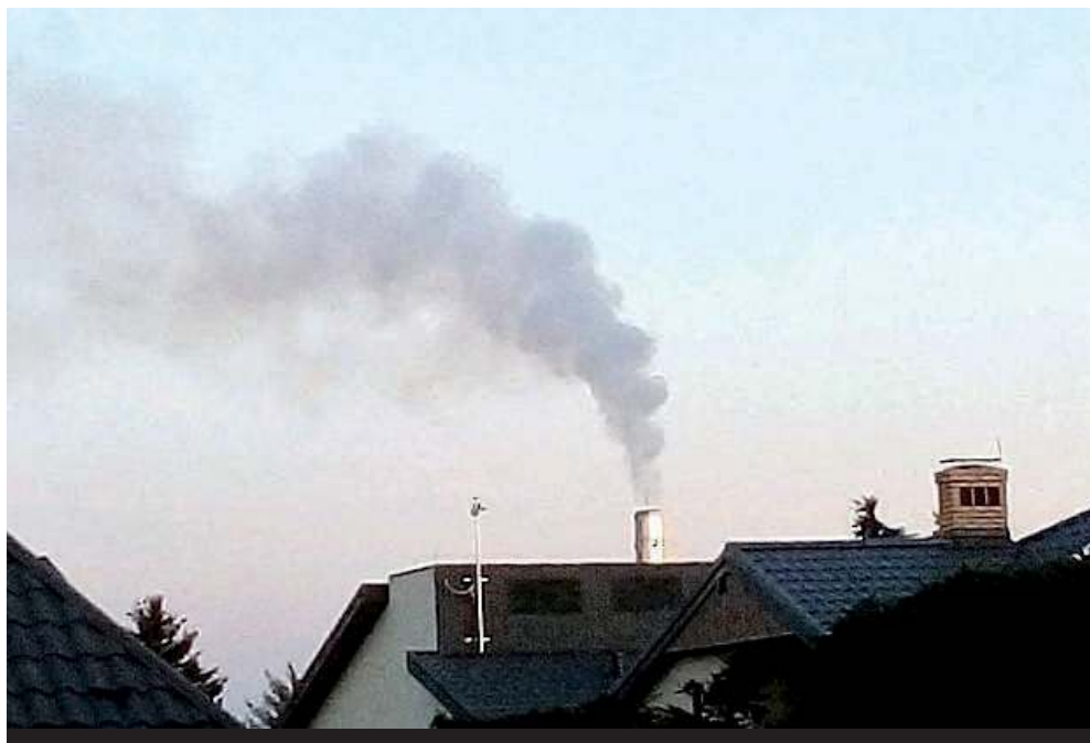
W lipcu ub.r. doszło do dwóch awarii pieca kremacyjnego
