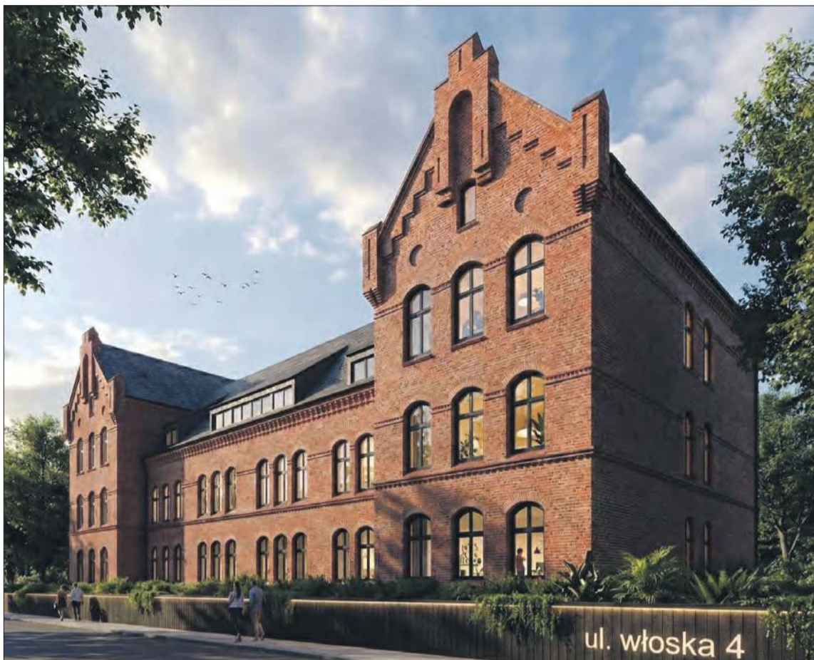
W budynku znajdują się około 22 mieszkania
