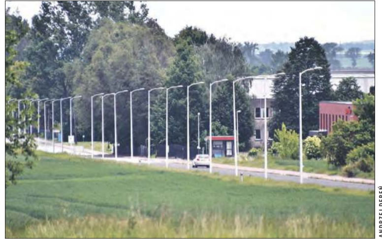
Ulica Przemysłowa w Prudniku
