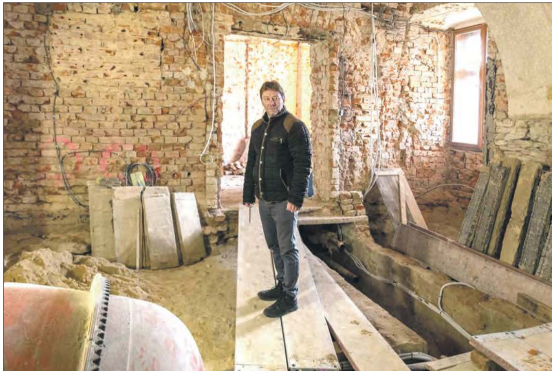
Starosta Martin Korduliak ogląda remontowanych pomieszczeń zamku
