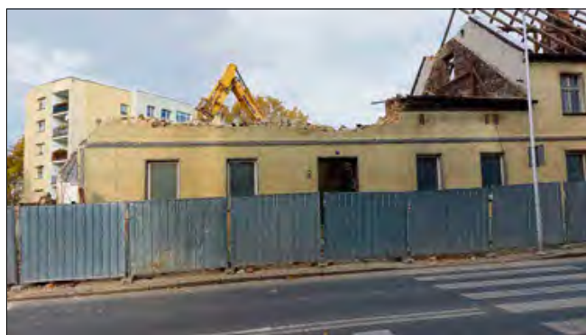
Rozpoczęto wyburzanie starych budynków przy ulicy Prudnickiej w centrum Krapkowic – teren przygotowywany jest pod nowy kompleks usługowo-mieszkalny.
