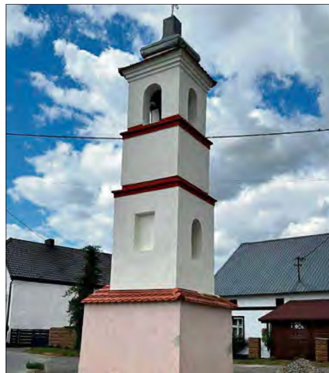
W ramach remontu wykonano szereg prac konserwatorskich i estetycznych.
