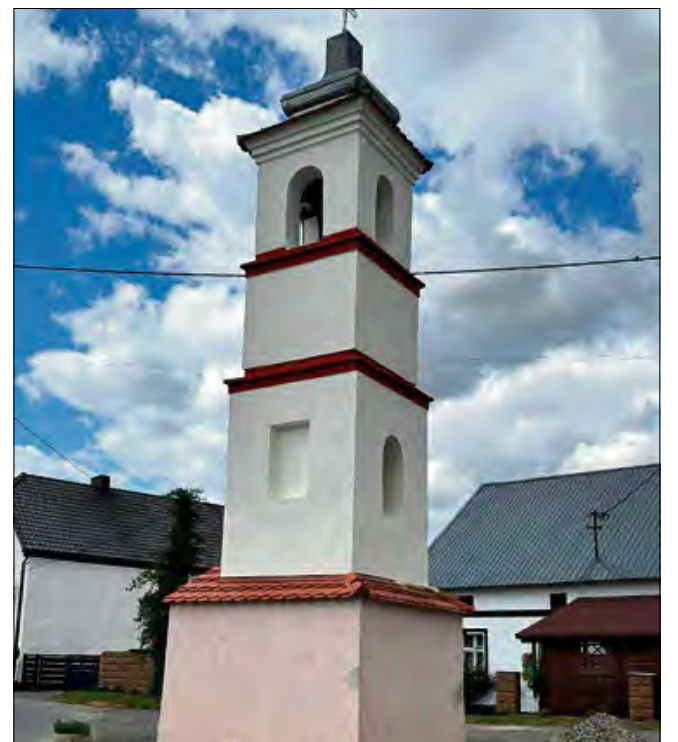
W ramach remontu wykonano szereg prac konserwatorskich i estetycznych.
