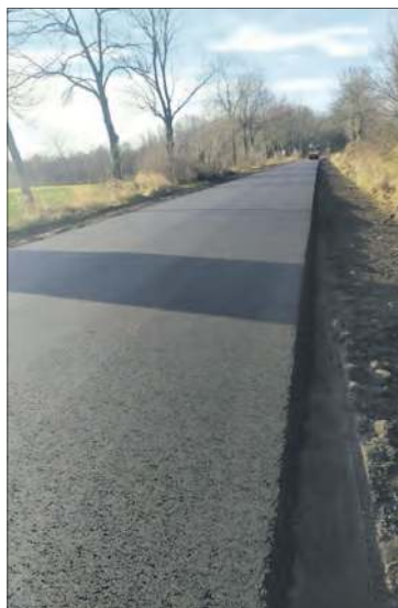
Nowa nawierzchnia drogi z Racławic
