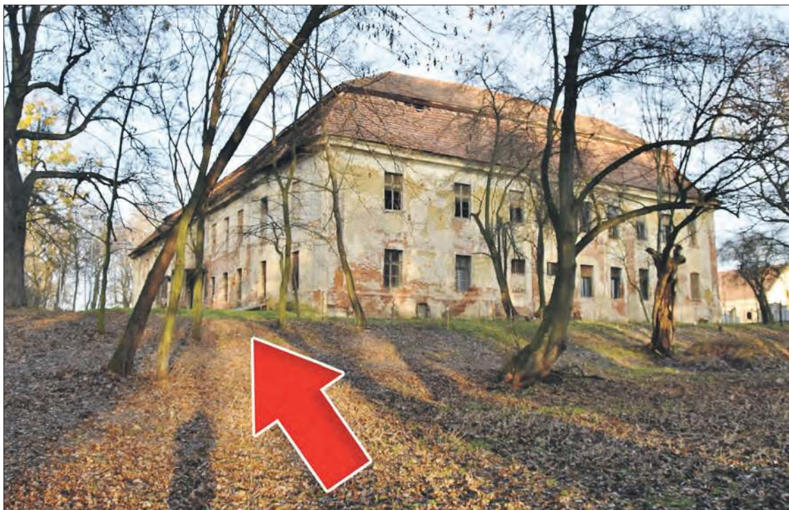
W tym miejscu znajdowała się wyburzona część dworu renesansowego
