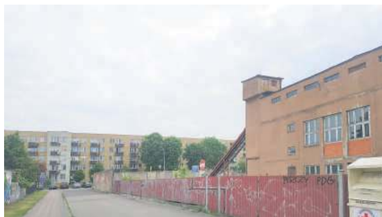
Tu na razie jest dawna kotłownia...
