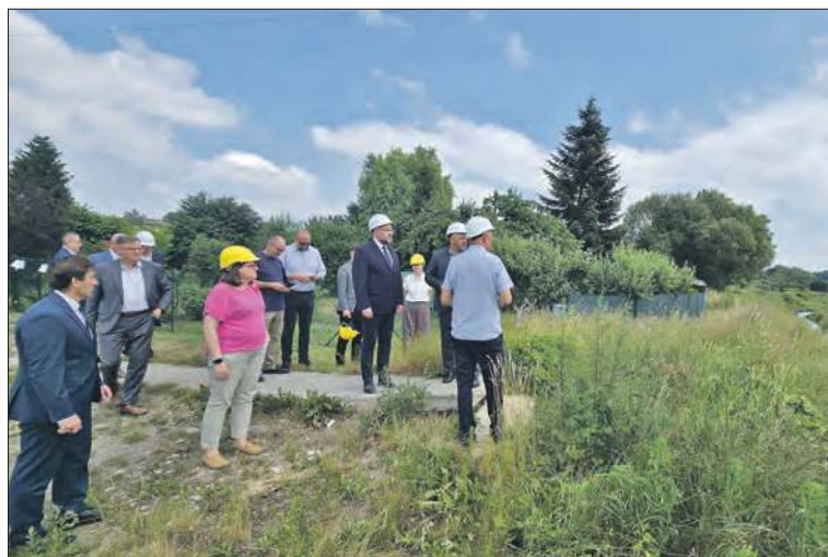
Przy zniszczonej kładce obok ul. Łuczniczej
