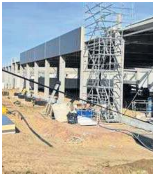
Trwa budowa pierwszej galerii handlowej w Łęczycy
