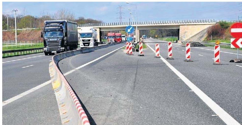
W trakcie poszerzania autostrady ruch ma być prowadzony na dwóch pasach
