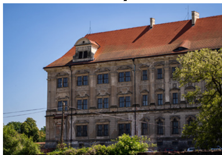
Fasada obiektu przytłacza ogromem.
