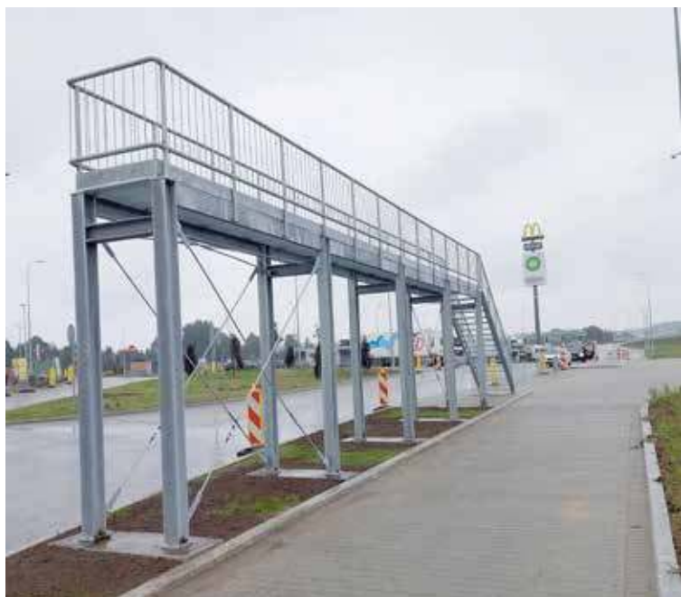
Rampa do odśnieżania pojazdów na MOP Widoma Zachód w ciągu S7 w woj. małopolskim (fot. GDDKiA)
