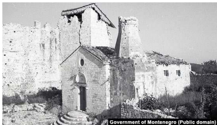
Zniszczony meczet w Ulcinj podczas trzęsienia ziemi w 1079 roku, źródło: www.rferl.org/a/montenegro-earthquake-1979/32907282.html
