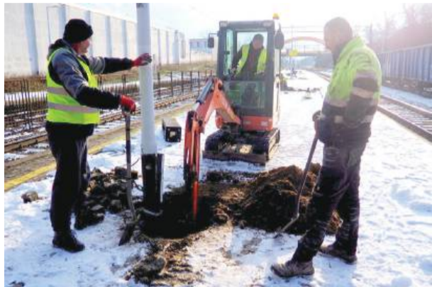
Inwestycję zrealizowano w ramach działania „Wymiana słupów oświetleniowych wraz z opravami na stacji Strzelin, linia kolejowa nr 276 Wrocław Główny – Międzylesie”
