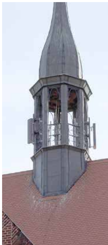
Dotychczasowy efekt prac na wieży kościoła jest już widocznych
