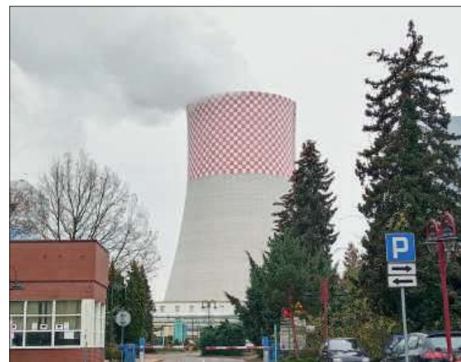
Chłodnia kominowa nowego bloku energetycznego w Elektrowni Jaworzno III.
