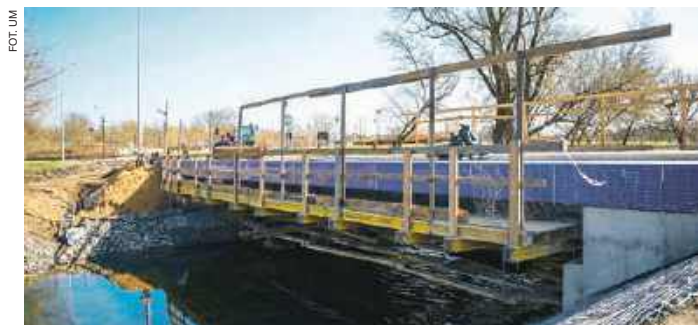
Remontowany most na ulicy Augustańskiej
