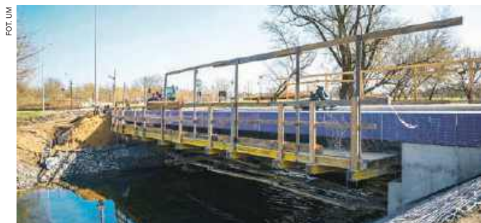
Remontowany most na ulicy Augustiańskiej
