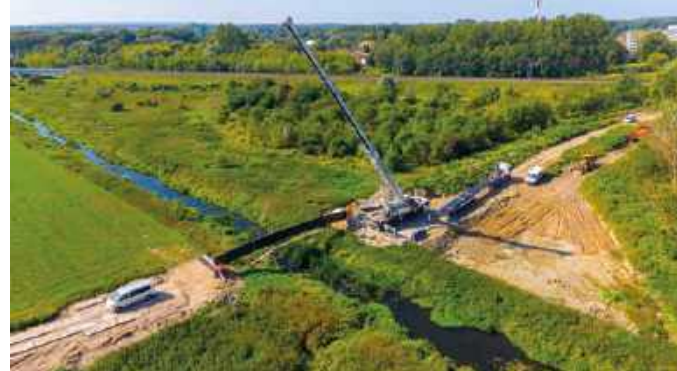
Budowa przeprawy przez Łydynię
