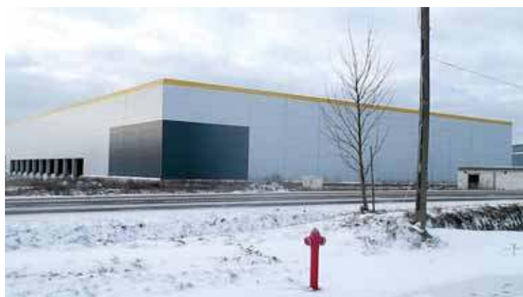
Hala magazynowa w Szydłowie, stan obecny
