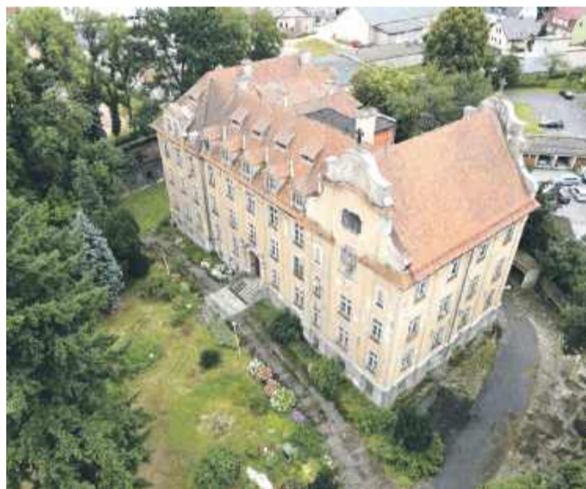
Zakupiony za 7,8 mln zł obiekt od ponad 4 lat stoi i niszczy
