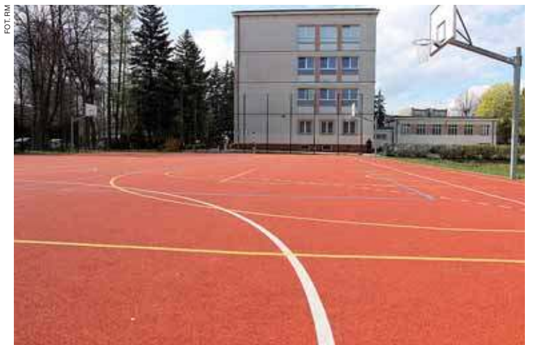
Wyremontowane boisko przy ZS nr 1 w Ciechanowie
