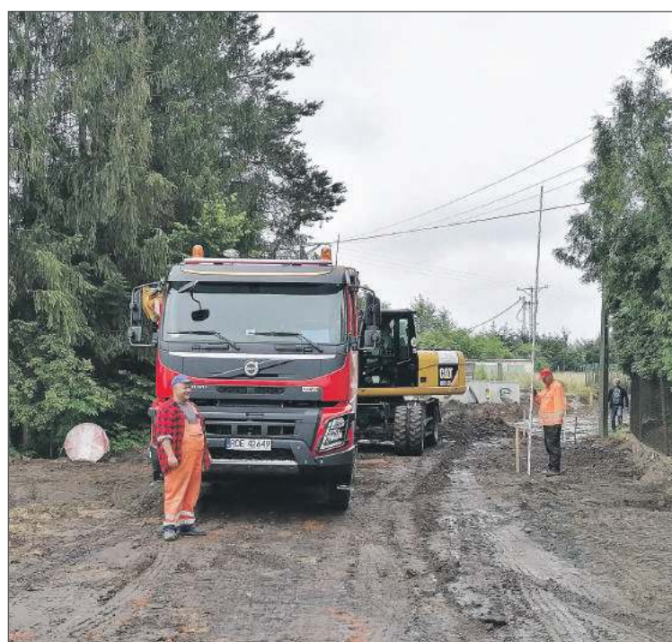
Na drodze trwają prace budowlane. Wykonawcą jest PDM z Dębicy.
