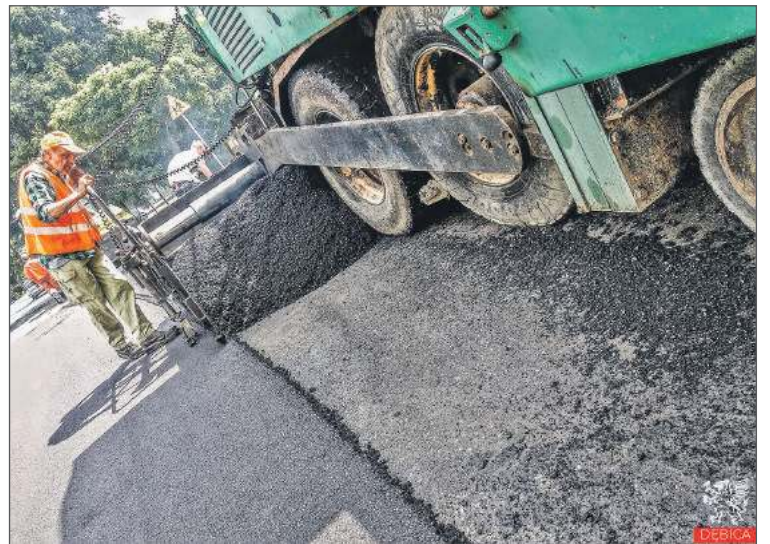
Na ul. Sportowej prace już się zakończyły.
