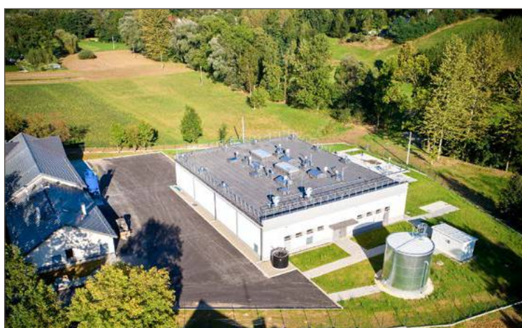
Oczyszczalnia ścieków w Jodłowej wciąż ma wolne moce przerobowe.
