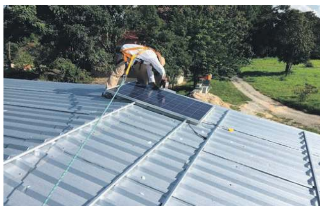
Montaż paneli na dachu domu
