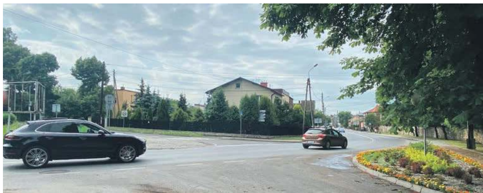
Skrzyżowanie ulic Piłsudskiego i Kościelnej czeka spora przebudowa
