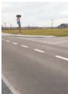
Przebudowana droga powiatowa nr 1051L
