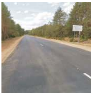
Przebudowana droga Nr H-424 po stronie białoruskiej
