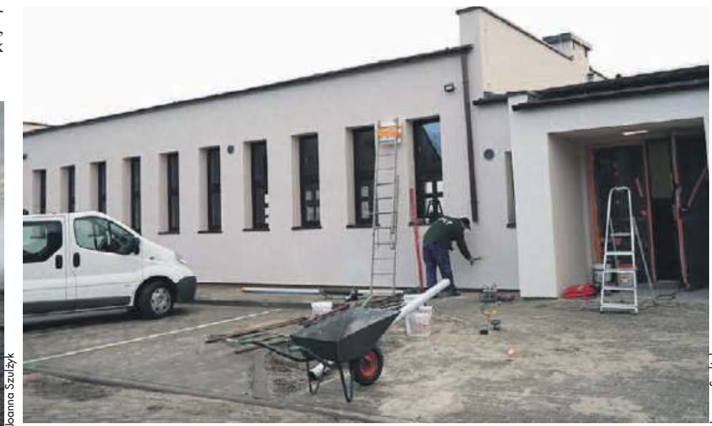
Remont zakładał także prace zewnętrzne
