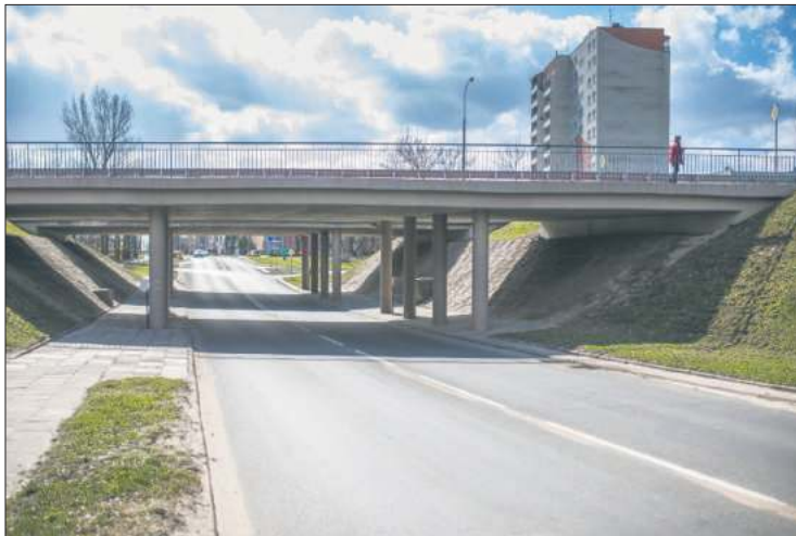
Wiadukt nad ulicą Spółdzielczą
