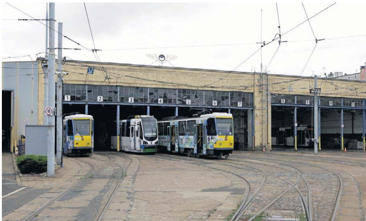
W hali zajezdni brakuje pomostów serwisowych niezbędnych do obsługi urządzeń znajdujących się na dachach tramwajów niskopodłogowych. Dodatkowo szerokość bram i odległości między torami są zbyt małe dla współczesnego taboru
