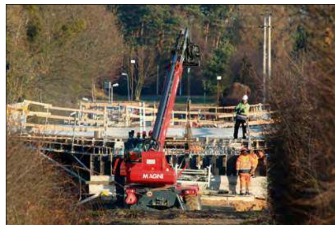
Budowa prowadzona jest równolegle z obu brzegów.
