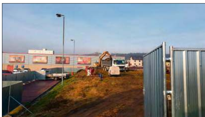
Plac budowy już gotowy.
