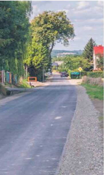
Klinkierniana doczekała się remontu.
