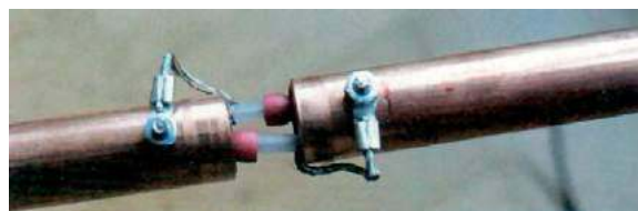
Fot. 3. Widok podłączonych kondensatorów
