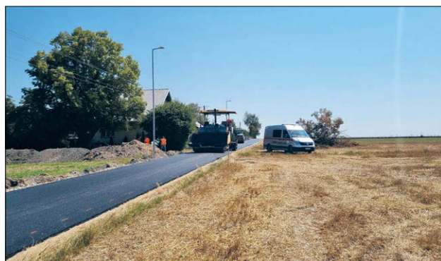
Roboty wykonywane są na półkilometrowym odcinku. Wykonawca realizuje je za kwotę 199 303,05 zł brutto
