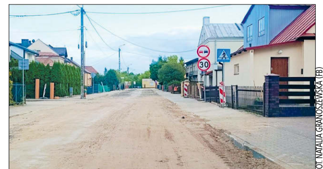
Wznowienie robót na ul. Chomiczewskiego planowane jest w połowie sierpnia
