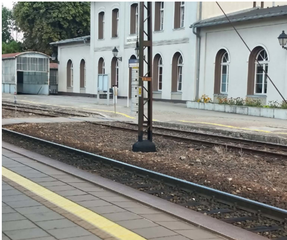
Stacja kolejowa w Brzegu Dolnym.
