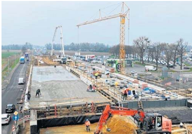
Budowaną właśnie estakadą w ciągu obwodnicy Opola pojedziemy na przełomie sierpnia i września.
