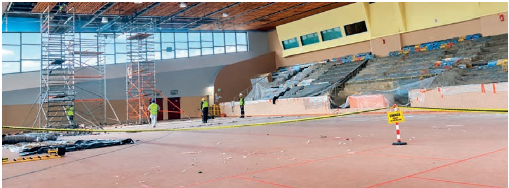
Prace w hali potrwają dłużej
