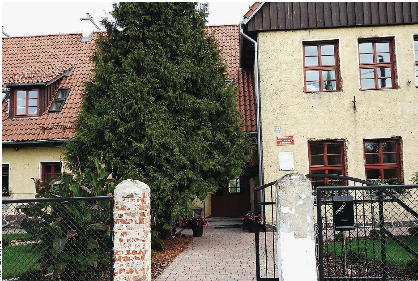
Niedawno remontowany budynek stoi pusty
