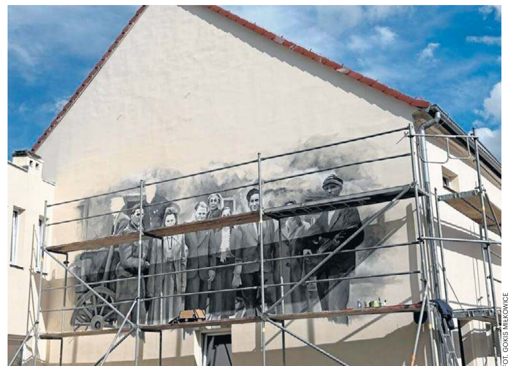
Arkadiusz Andrejkow tworzy mural na ścianie sali wiejskiej, gdzie odbywały się próby i przedstawienia
