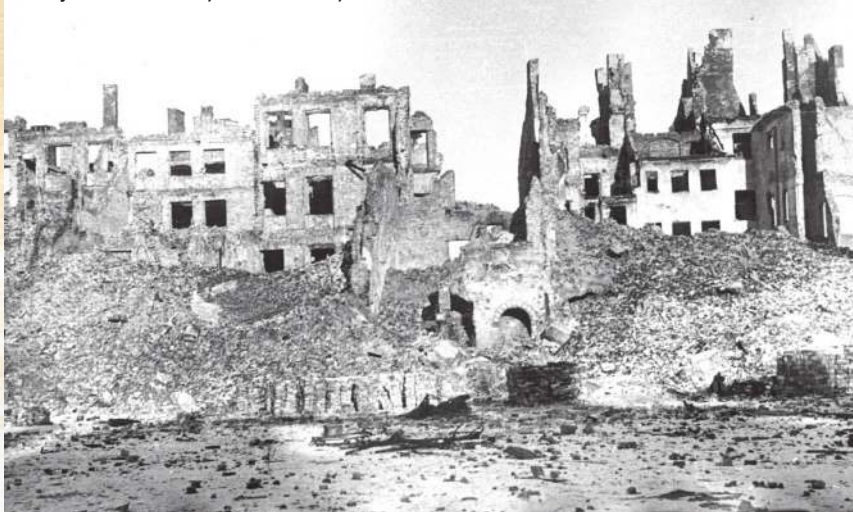
Zrujnowane budynki na Starym Mieście.
