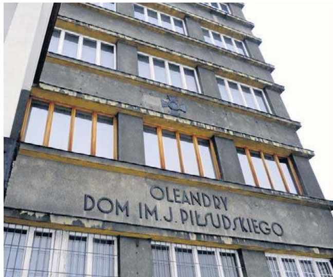
Budynek przy Oleandrach wciąż czeka na remont, uratowane eksponaty przeszły już konserwację
