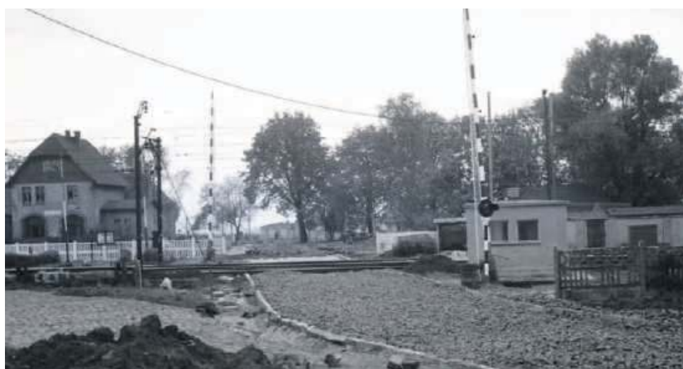
1971 - budowa przejazdu na czas budowy wiaduktu pomiędzy ulicą Różaną a Małodworcową. W głębi po lewej budynek dworca kolejowego linii Oława - Boreczek. Dziś w tym budynku po przebudowie są mieszkania
