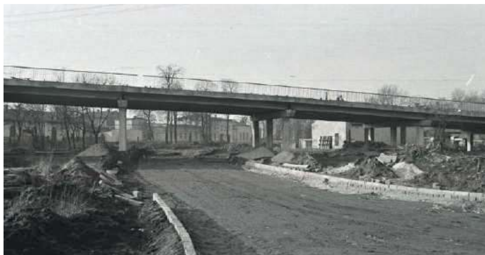
1973. Budowa wiaduktu od strony ul. Różanej. W głębi budynek stacji, wyburzono wtedy wszystkie budynki na trasie planowanego łącznika. Zaznaczam, że w tym czasie objazd ulicą Różaną cały czas się odbywał
