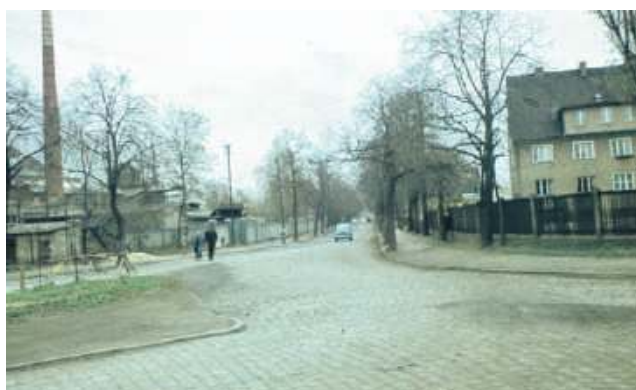
1972. Skrzyżowanie ulicy Różnej i Wł. Sikorskiego. Tędy odbywał się ruch na trasie Wrocław-Opole w czasie budowy wiaduktu
