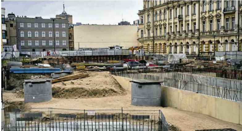
• Budowa przystanku Łódź Śródmieście na trasie tunelu średnicowego, 21 maja 2025 r. FOT. TOMASZ STAŃCZAK / AGENCJA WYBORCZA.PL
