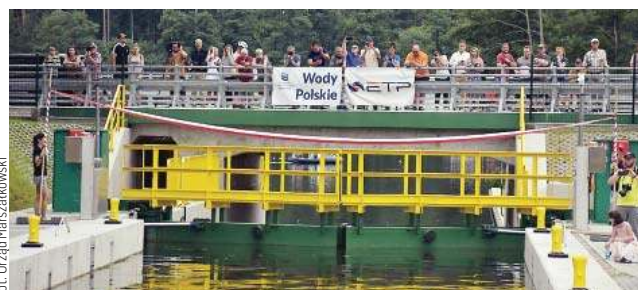
Śluza po remoncie
