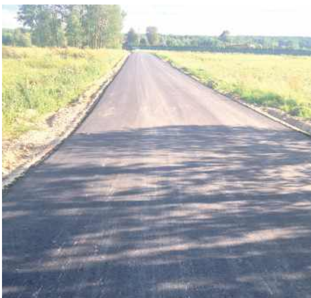
Trwają prace w Zbójnie
