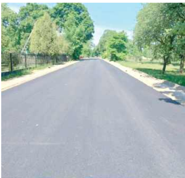
W Kropiawkach został ułożony nowy asfalt
