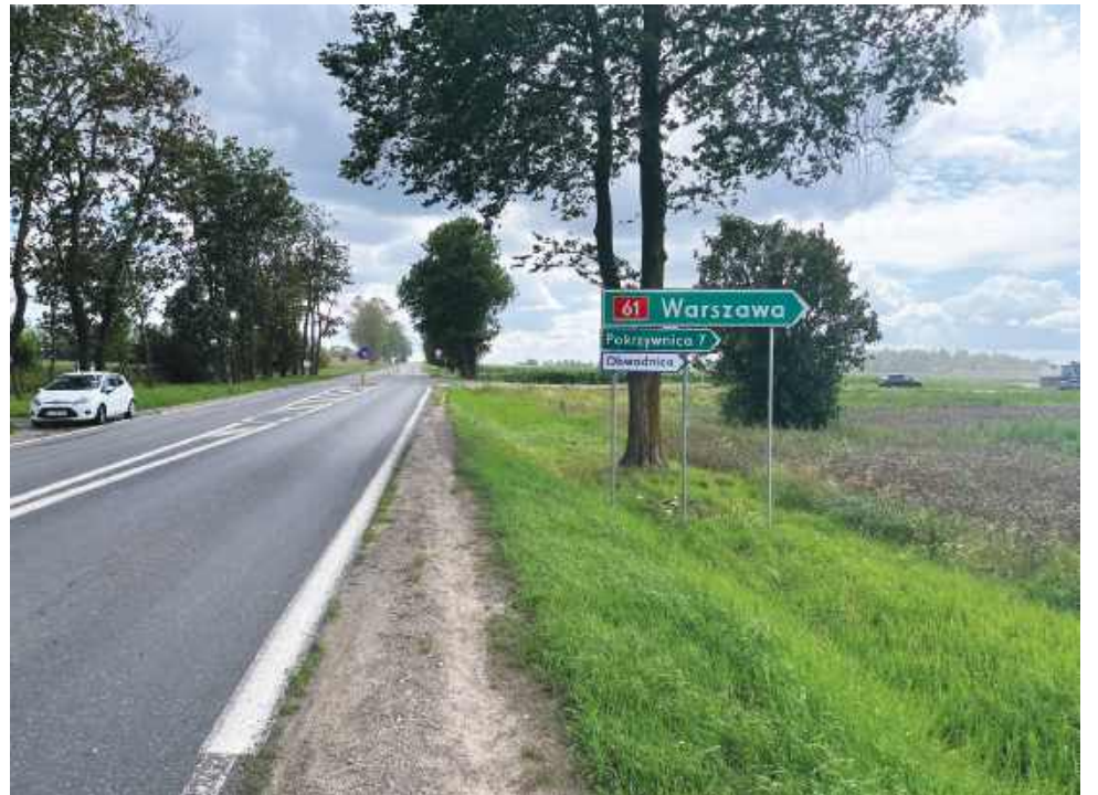
GDDKiA zgodnie z zapowiedzią usunęła zapory na wjeździe na stary odcinek DK61 w Kacicach
