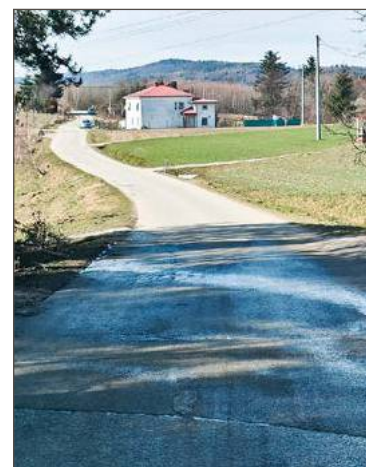
Wyremontowana zostanie m.in. droga Wisowa Zachód.
