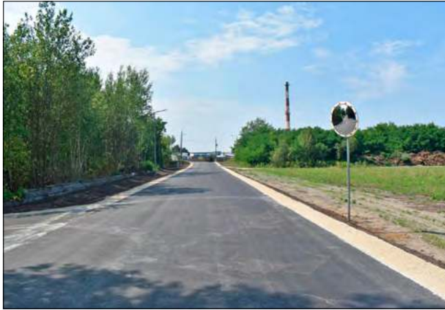
Na przebudowę ul. Technicznej w Schodni pozyskano zewnętrzne dofinansowanie.
