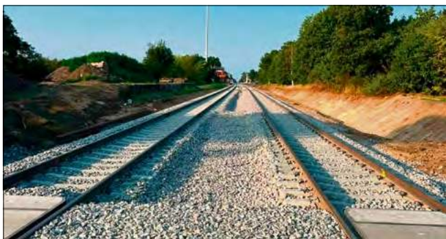
Przywrócenie ruchu kolejowego pomiędzy Opolem a Jełową to ważny krok w realizacji inwestycji wartiej około 230 mln zł.
