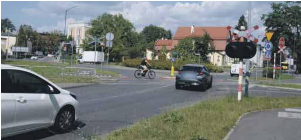
Chyba jedno z najniebezpieczniejszych obecnie miejsc w Tarnowskich Górach: gęszcz znaków, zjazd z ruchliwego ronda, a przy nim zbiegające się przy przejeździe dwie drogi rowerowe, tuż obok tory wąskotorówki, a nieco dalej przejście dla pieszych
