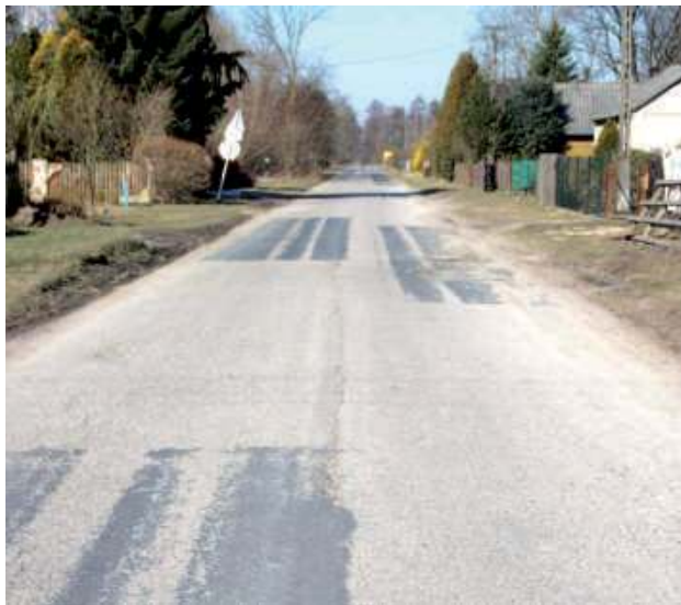
Jeszcze w tym roku mieszkańcy Chrzachówka będą jeździć po nowym asfalcie i poruszać się po chodniku
