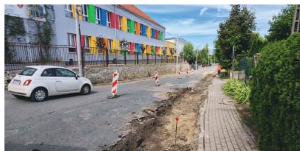
Inwestycją objęty jest także odcinek drogi od skrzyżowania przy krzyżu do szkoły
